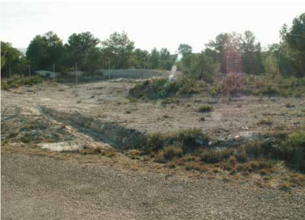
En la Balsa de la Carrasquilla (Enguera), se recuperó la cuneta de la carretera que le llevaba el agua a la charca.
