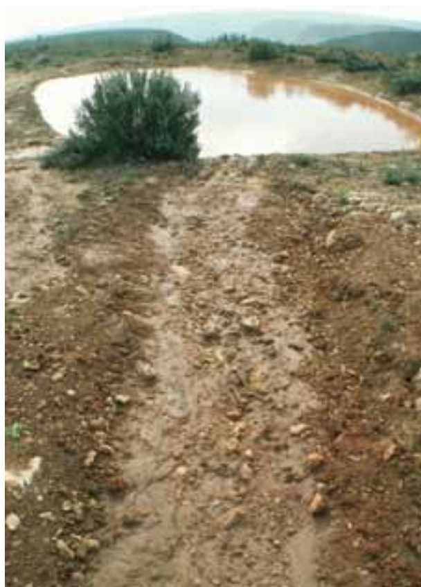
La alimentación hídrica de las charcas, especialmente las temporales, hay que buscarla en el agua de lluvia, mejorando las cunetas de escorrentía. Balsa de Valladinos (Enguera).
