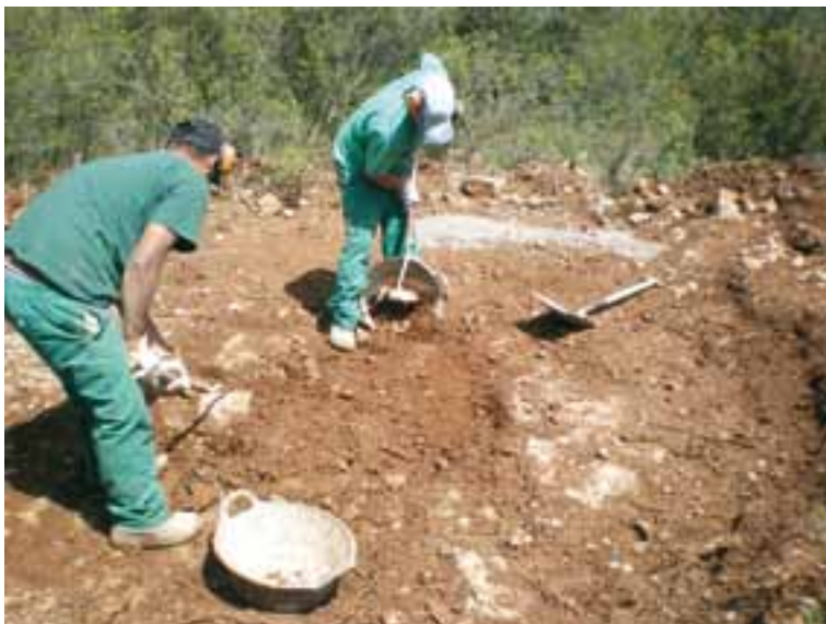
Excavación manual de una pequeña charca. [Foto: Ramón Ezpeleta]
