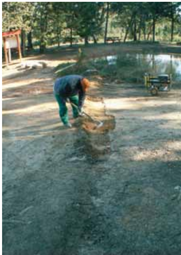
La mejora de las cunetas es fundamental para garantizar el aporte de agua. En ocasiones es necesario recrear una pequeña mota en los caminos adyacentes a la charca, como en la Bassa del Surar (Llutxent).
