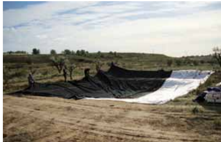
Sobre el geotextil se extiende la lámina de caucho.
