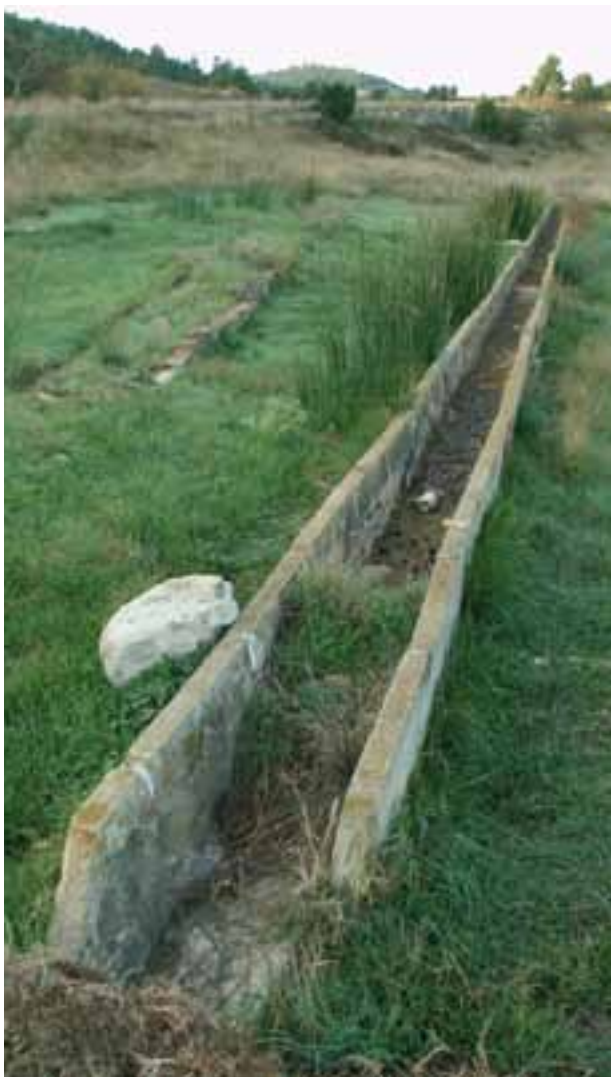
Manantial de la Canaleta (Higueruelas). La pérdida de uso ha ocasionado su abandono y la rotura del abrevadero.
