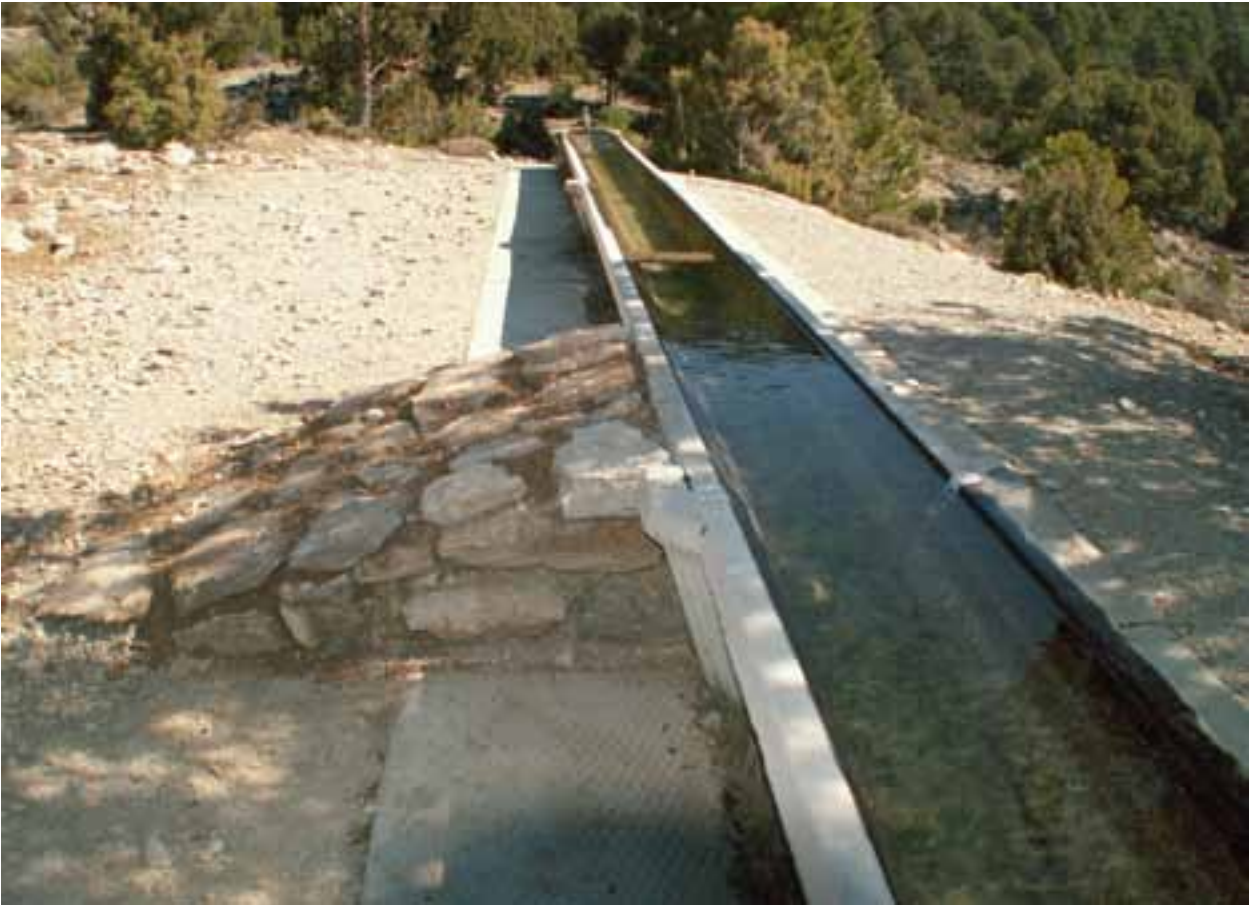
Fuente del Maderero (La Puebla de San Miguel). Instalación de una pequeña rampa de acceso a un abrevadero de paredes verticales.
