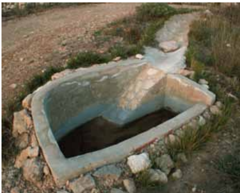
Pequeña arqueta instalada en una cuneta de escorrentía utilizada como trampa de sedimentos. Además sirve de punto de reproducción para el sapo partero. Estación Biológica Torretes (Ibi).
