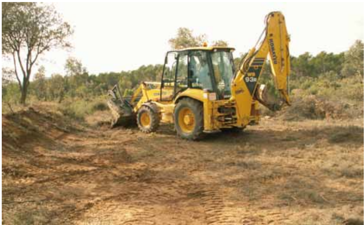
Excavación de una charca mediante retroexcavadora mixta.
