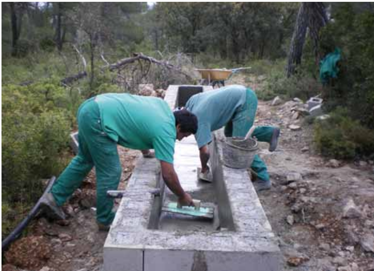
Construcción de un abrevadero. [Foto: Ramón Ezpeleta]
