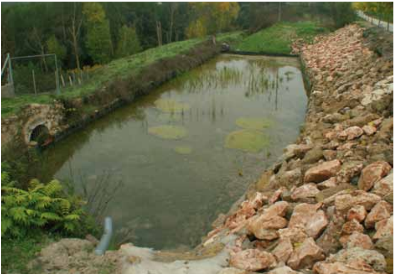
La misma balsa una vez restaurada.
