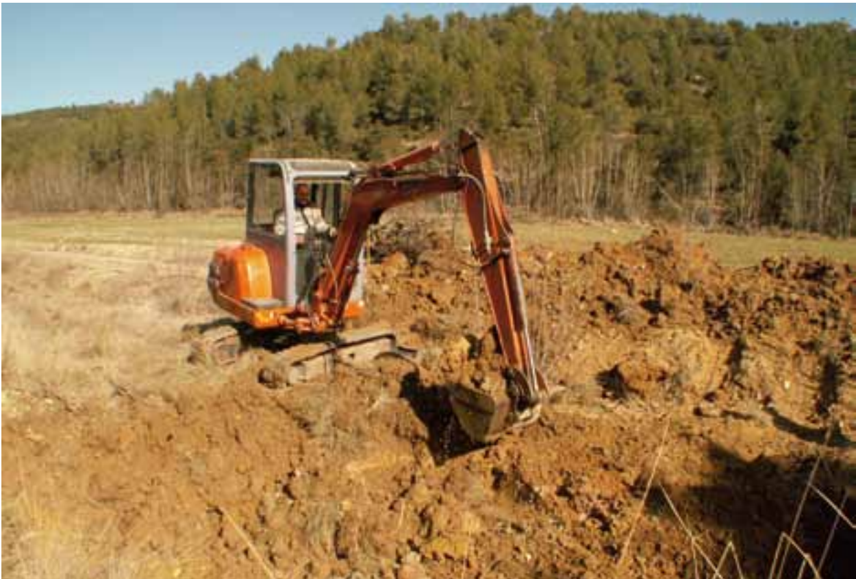
Las Aguazuelas (Requena). Creación de pequeños prados húmedos con miniexcavadora.
