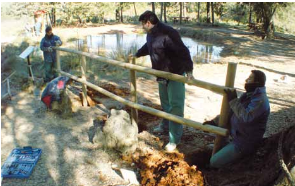
Instalación de un vallado de madera. Bassa del Surar (Llutxent).
