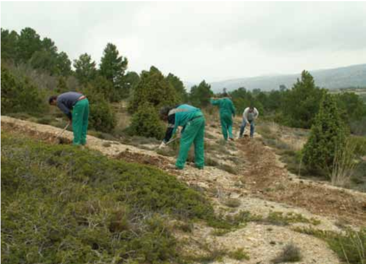
Recuperando las cunetas de escorrentía del Navajo de Cueva Negra (La Yesa).
