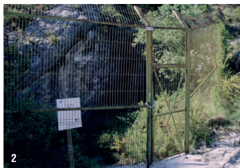
Figura 5. Vallados instalados por otras entidades para evitar la entrada de personas en lugares con colonias de murciélagos: 1. Molí de la Font en Castellón de la Plana, 2. Cova Joliana en Alcoi.
